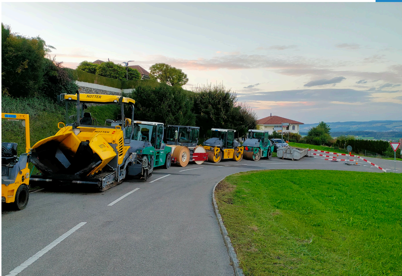
Sanierung Niesenbergstrasse im September 2024
